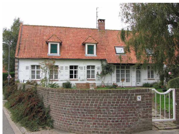
Pour la création de nouveaux percements en toiture, privilégier la mise en œuvre de petits châssis de toit. La création de lucarne doit rester très limitée et s'inspirer de modèles existants déjà sur la toiture ou à proximité. Ces nouveaux percements doivent être composés avec les ouvertures de la façade.
