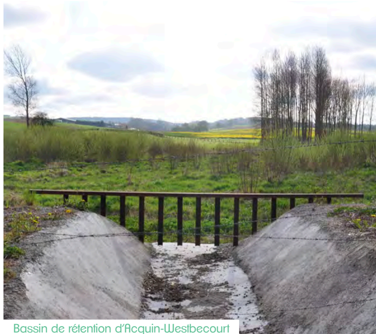
Bassin de rétention d'Acquin-Westbecourt
