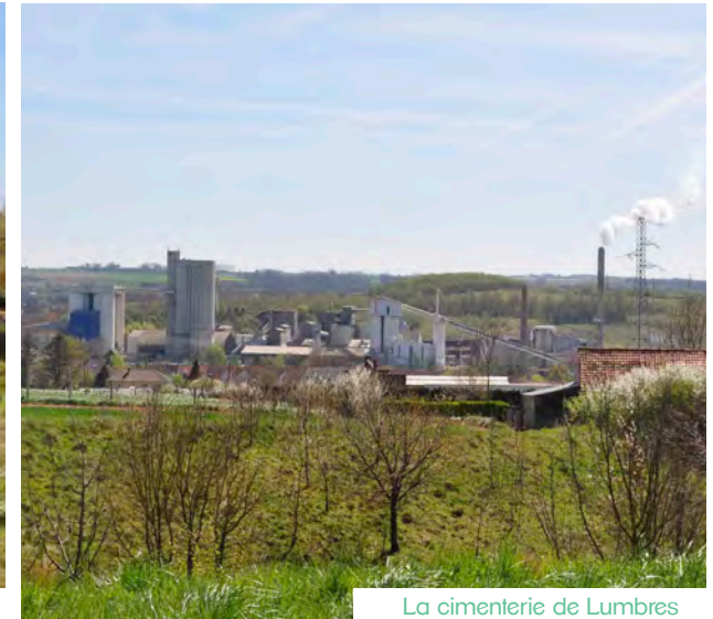
La cimenterie de Lumbres
