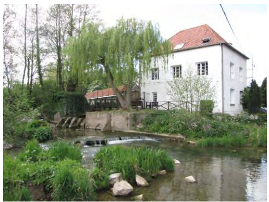
ILLUSTRATION 16. FRICHE INDUSTRIELLE À OUIVE-WIRQUIN - ANCIENNE GARE À NIELLES-LES-BLÉQUIN - ANCIENNE FORGE À COULOMBY - POUDRERIE D'ESQUERDES - MOULIN À CLERQUES (AUDENFORT) - (CHHP)
