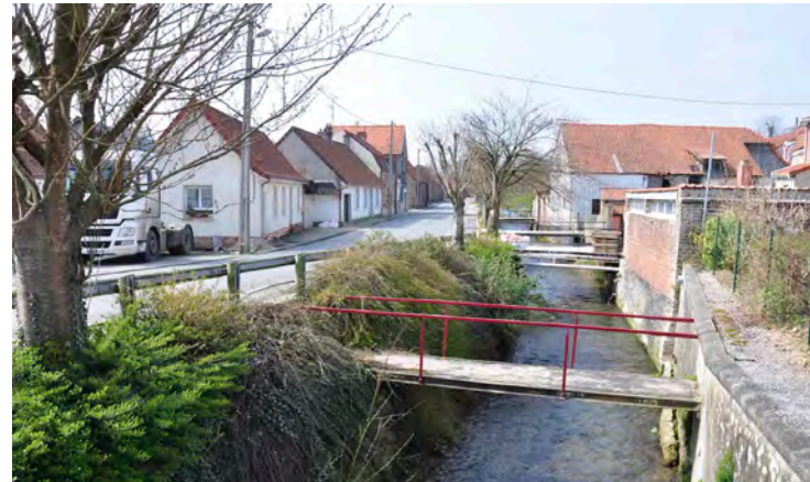
Aménagement renforcé sur le Blécquin : hauts soutènements en béton
