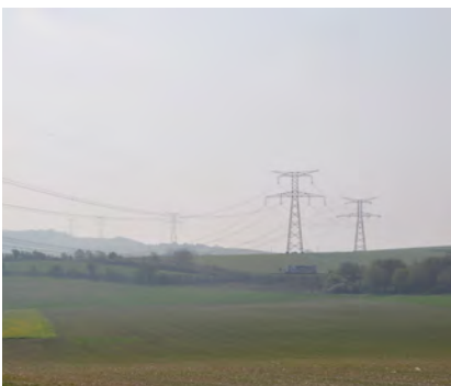
Ligne THT au Sud Ouest de la CCPL
