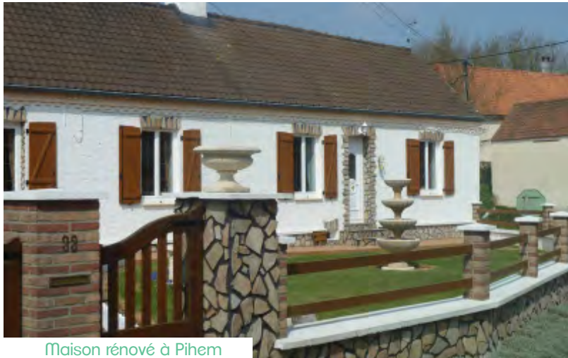
Maison rénové à Pihem
