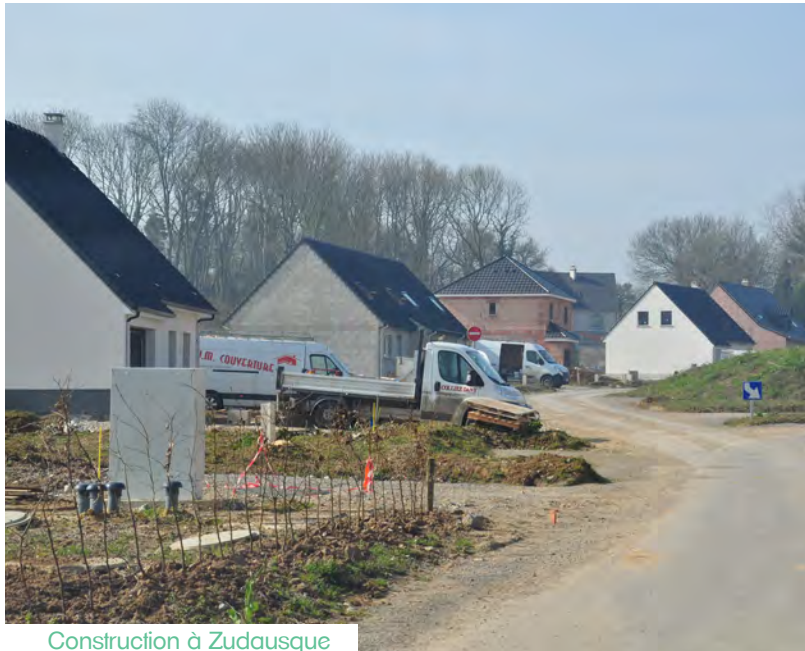
Construction à Zudausque
